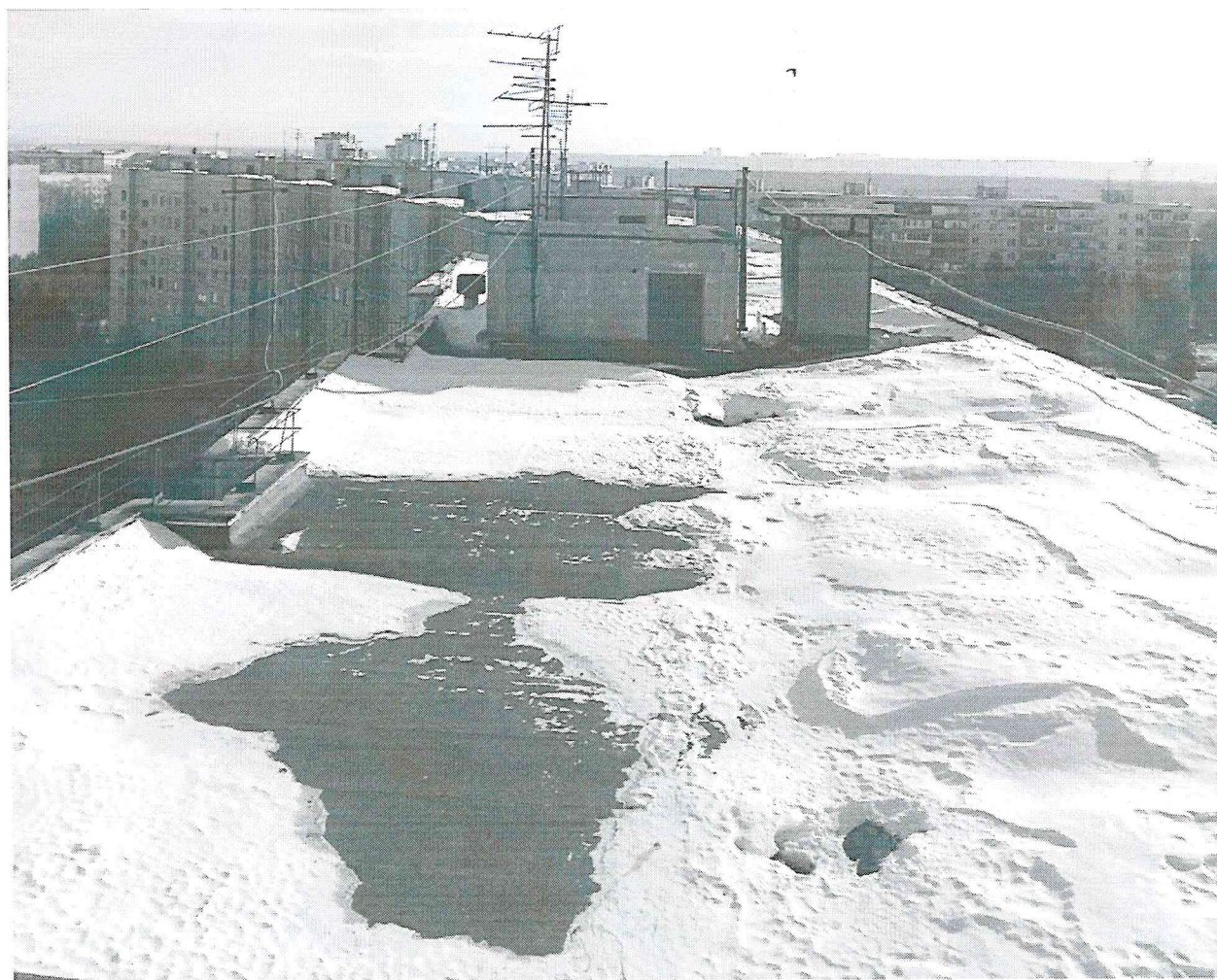
Общий вид крыши по состоянию на март 2021г.
